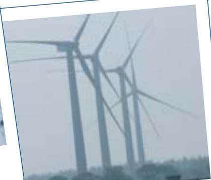
Mission accomplie pour les deux alignements de quatre éoliennes
