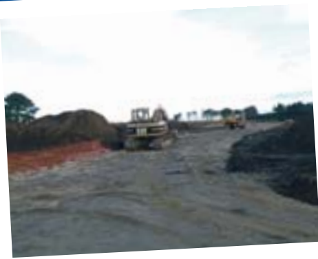
Premiers coups de « pioche » : décapage des bases des ouvrages
