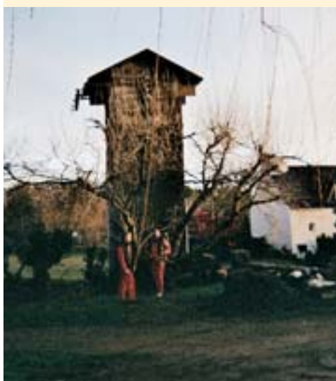
2007 : démolition du transformateur.
